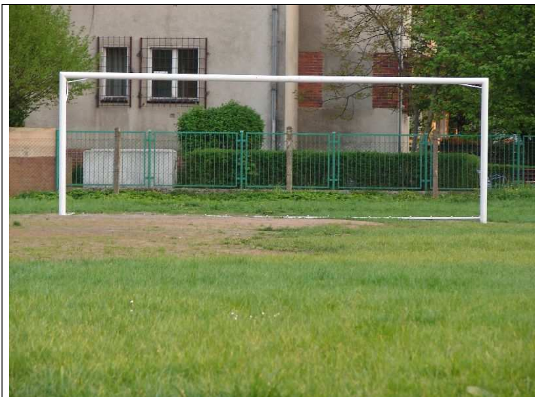
Fot.4. Wyraźne błędy w globalnym kształtowaniu nawierzchni boiska. Widoczne gołym okiem wzniesienia i obniżenia terenu. Wyraźnie widać, że lewy słupek bramki jest znacznie wyżej niż prawy słupek. Ponadto przed polem karnym stworzyła się niecka, w której w razie opadu atmosferycznego będzie się gromadziła woda.
