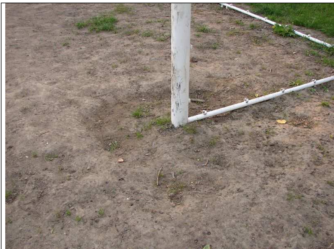
Fot.1. Widoczne gołym okiem wyraźne nierówności w rejonie pola karnego, których różnica poziomów sięga lokalnie aż do 14 cm!! Przeprowadzony remont w żadnym stopniu nie poprawił stanu nawierzchni ,a nawet go pogorszył.
